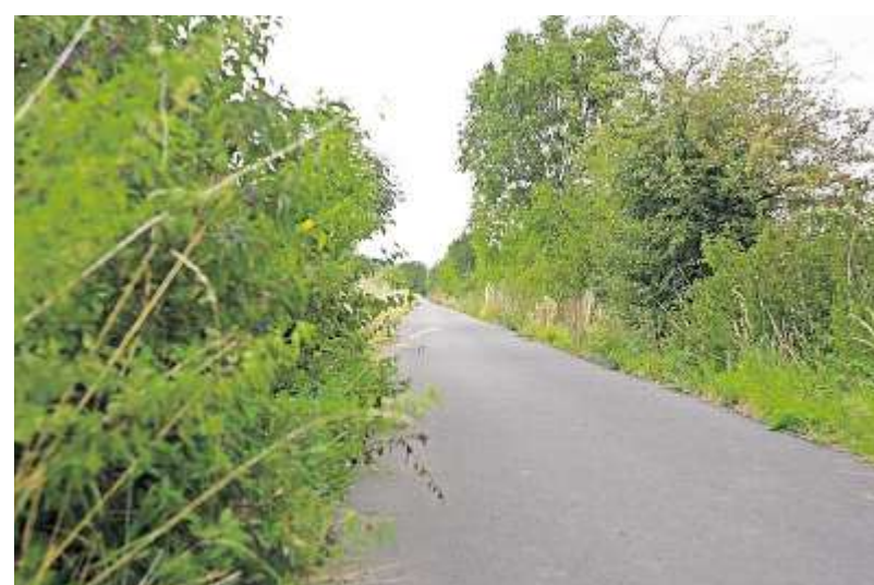
Die Gemeinde hat bereits begonnen, den Wildwuchs am Feldatal-Radweg bei Neidhartshausen zu beseitigen.
